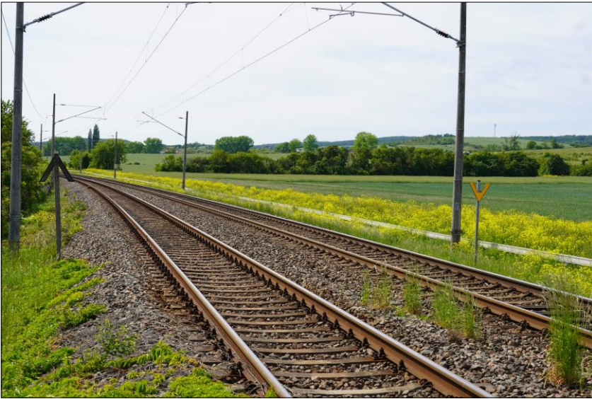
Bahngleise/-dämme in Roßla
